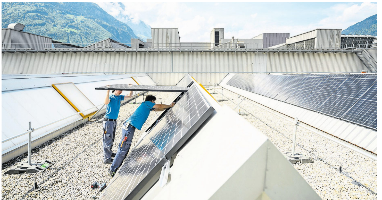
Installateure bei der Montage der Solarpanels.
